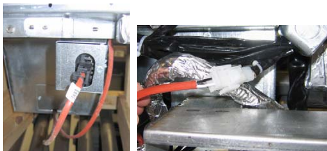
Figura 6: Prenda os conectores brancos de dois pinos e conecte o conector preto na tomada, conforme mostrado. * A posição do conector preto pode diferir em relação à foto.
